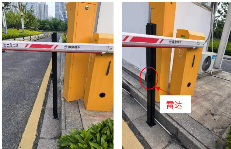
图 5 采用立柱安装
