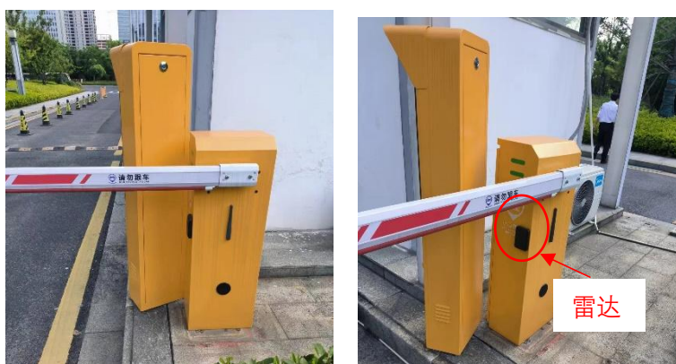
图 4 雷达扇面被车牌识别遮挡
